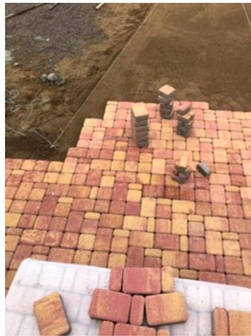
Фото - при укладке плитки ColorMix соседние камни максимально отличаются друг от друга по цвету
